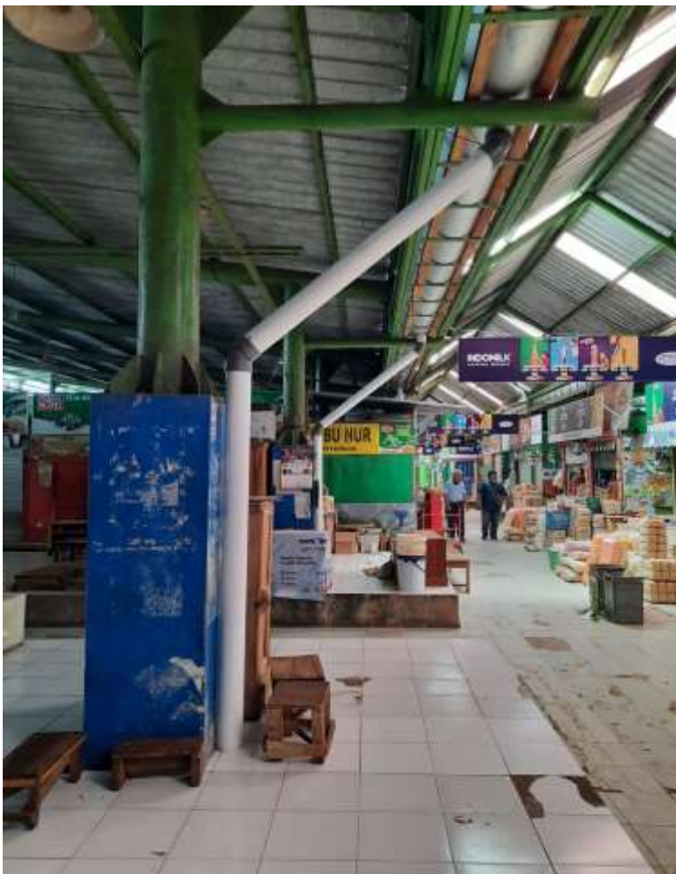
Rehabilitasi Pasar Piyungan
